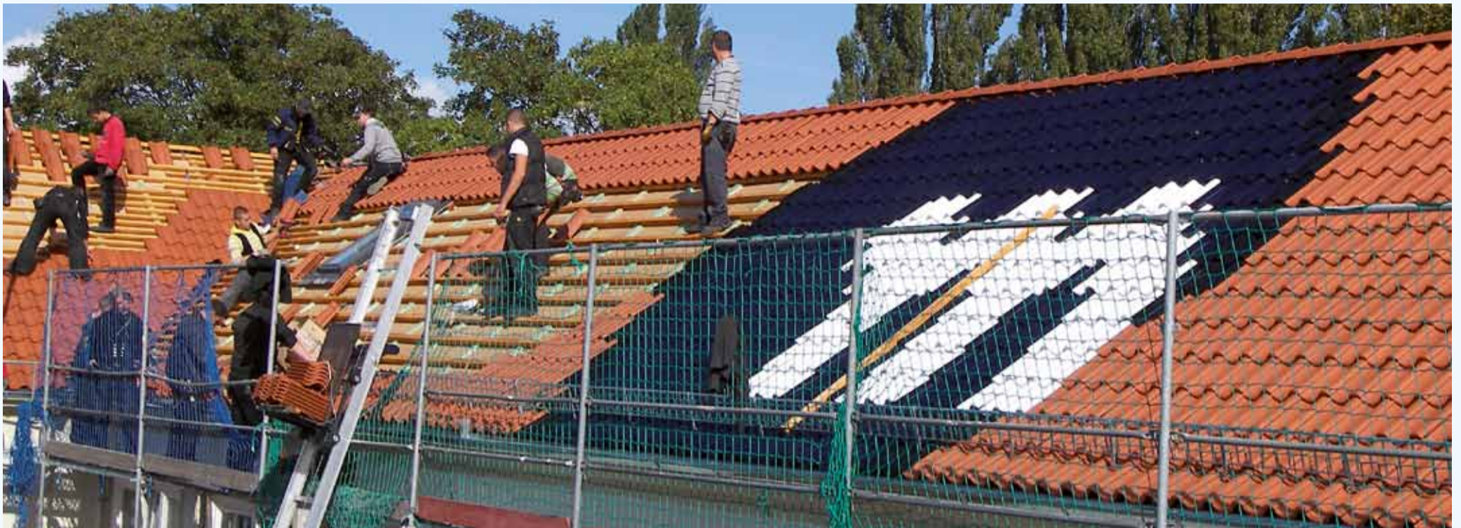
2011: 18 Auszubildende des Dachdeckerhandwerks stellen das neue Dach fertig
